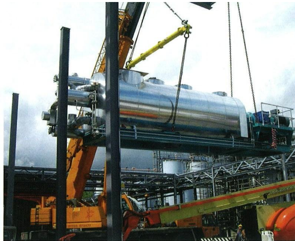
Eine kürzlich errichtete Anlage in Sheffield kann stündlich 2000 Kilogramm an schädlichen, ölhaltigen Abfällen aufbereiten.
