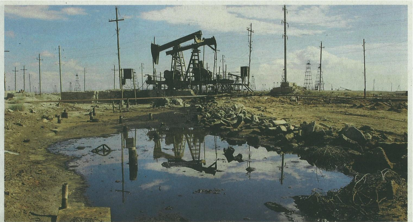
Mit Öl durchränkter Boden inmitten des Förderfelds „Bibi Heybat“ in Baku am Kaspischen Meer. Die Starnberger Firma „Econ Industries“ ist auf die Aufbereitung und Entsorgung solchen Problemmülls spezialisiert.
